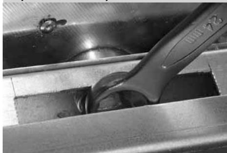
Примечание! Панель с электрической соединительной коробкой можно только отпустить, но не отстранить с рамы рекуператора. Ротационный теплообменник должен быть отсоединен от электрического ввода!
