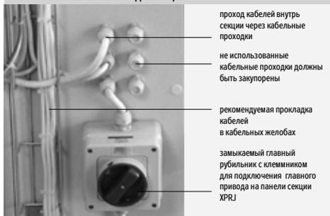
Трассы силовой части рекомендуется вести вдоль опорной рамы, трассы КИП и автоматики вдоль передней грани на верхней панели.
