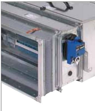
Подсоединение к каналу воздуховода должно осуществляться при помощи гибкого соединения, препятствующего переносу вибрации и обеспечивающего герметичность канала воздуховода и выходного отверстия установки на всасывании и нагнетании.
