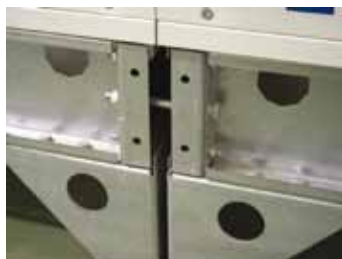
→ spojení podstavních rámců
