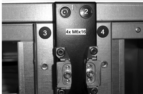
Obrázek 23 – demontáž mezidveřního sloupku
