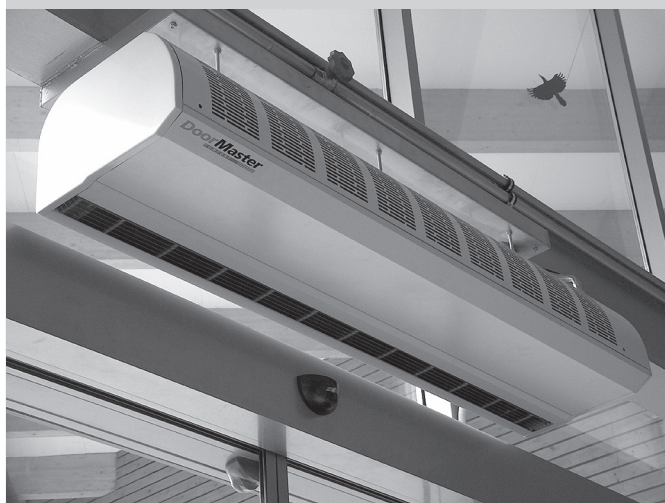
Obrázek 3 – instalace nad vchodové dveře
