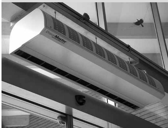
Clony jsou přizpůsobeny pro zavěšení na závitové tyče M 8 pomocí závesných profilů (standardní vybavení clony), clony C1 lze variantně zavěsit na nástenné závesné konzoly (volitelné příslušenství).
