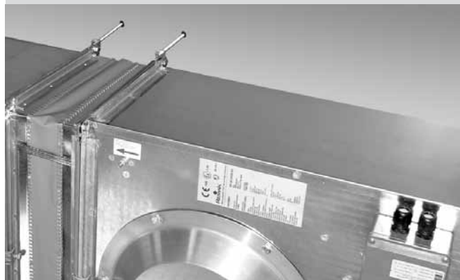
Obrázek 10 – ukotvení ventilátoru
