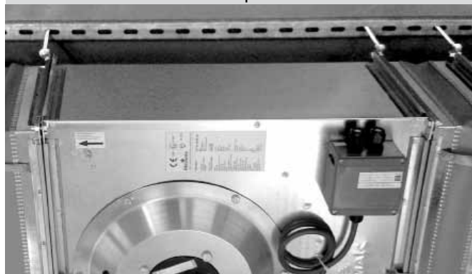
Obrázek 11 – zavěšení na pomocnou konstrukci
