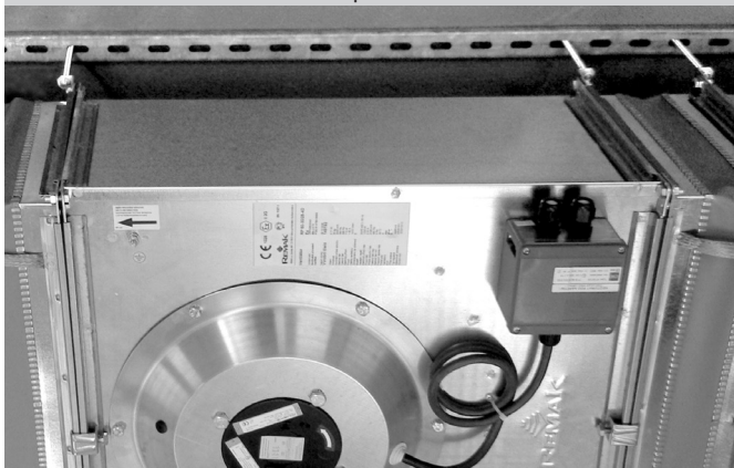
Obrázek 14 – zavěšení na pomocnou konstrukci
