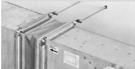
Obrázek 13 – ukotvení ventilátoru
