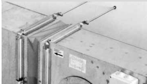
Obrázek 2 – ukotvení ventilátoru
