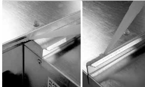
Obrázek 10 – utěsnění stříšek
