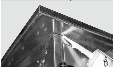
Obrázek 13 – utěsnění rubu stříšky
