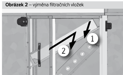
Obrázek 2 – výměna filtračních vložek
