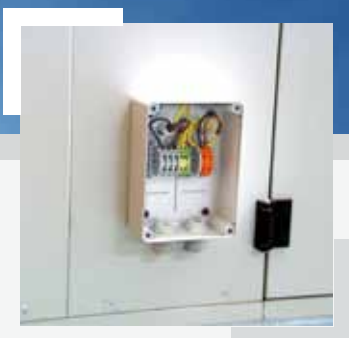
KLEMMKASTEN FÜR ELEKTRO- ANSCHLÜSSE
