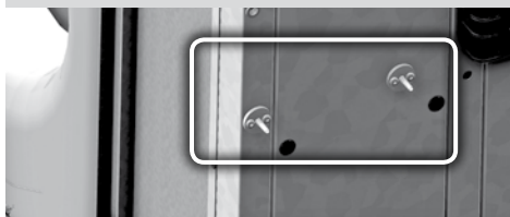
Fig. 25 – fan sampling probes
