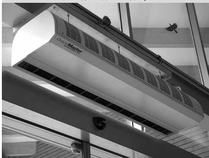
Рис. 3 – монтаж над входными дверями
