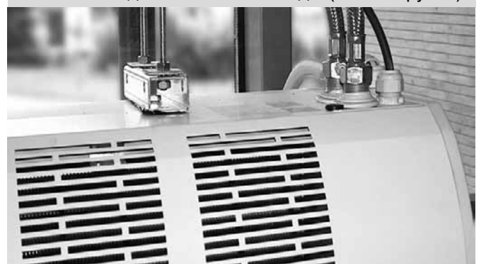
Рис. 13 – подключение отоп. воды (гибкие трубки)
