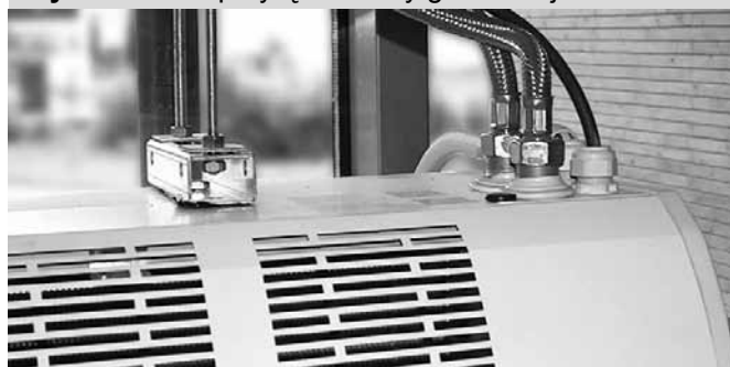
Rysunek 13 - przyłącza wody grzewczej
