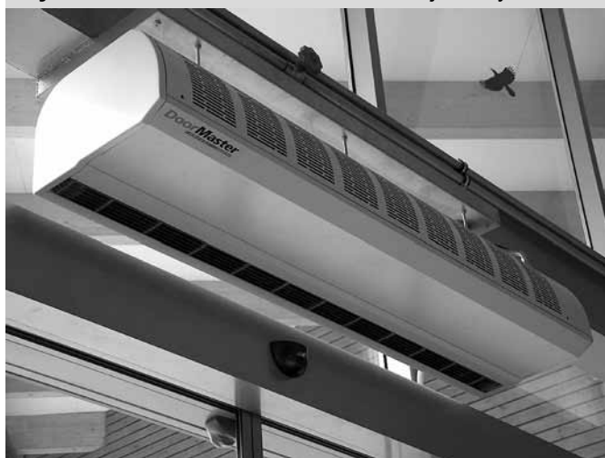
Rysunek 3 - montaż nad drzwiami wejściowymi
