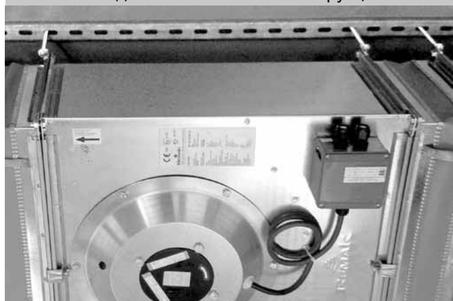
Рис. 11 – подвеска на вспомог. конструкцию
