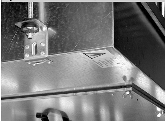
Rysunek 21 – zawieszenie na „zawiesie Z”
