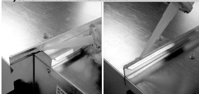
Rysunek 9 – uszczelnienie daszków
