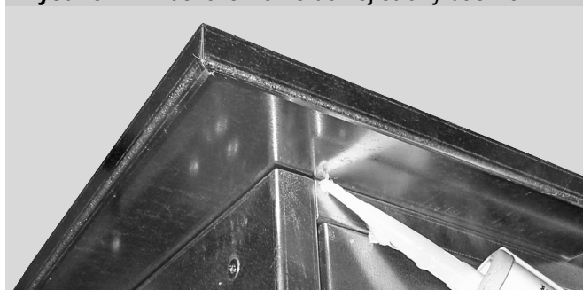
Rysunek 12 - uszczelnianie dolnej strony daszka
