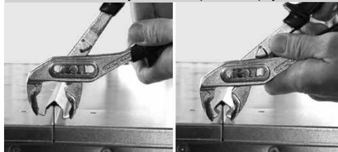
Obrázok 12 – zakrytie a zabezpečenie spoje striešok
