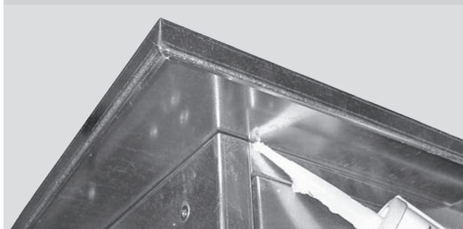
Slika 12 - zatesnitev hrbtni strani strešice
