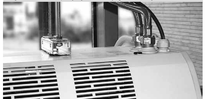
Rysunek 13 - przyłącza wody grzewczej
