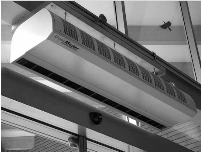
Rysunek 3 - montaż nad drzwiami wejściowymi
