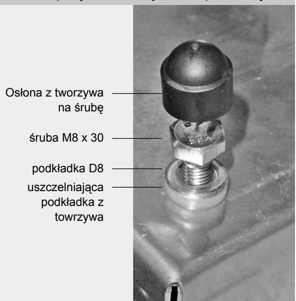
Rysunek 3 – połączenie wentylatora z podstawą
