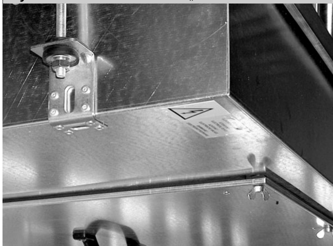
Rysunek 21 – zawieszenie na „zawiesie Z”
