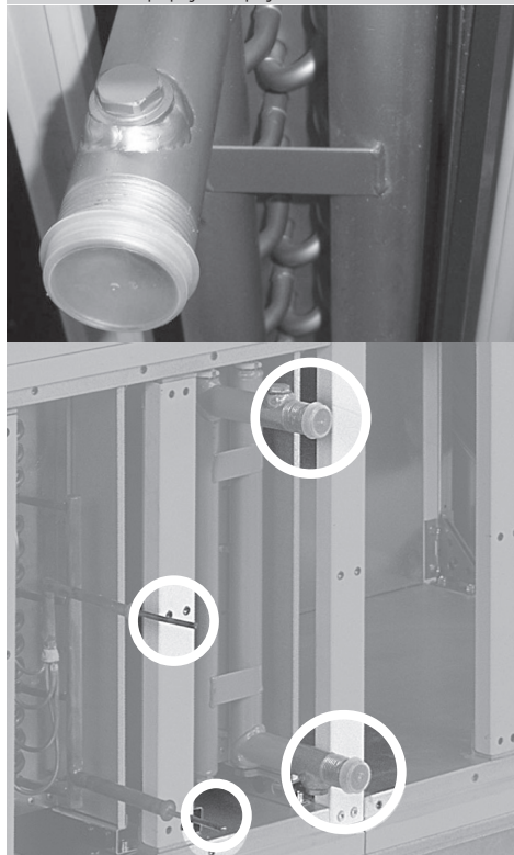
Obrázek 16 – připojení topných/ chladicích médií
