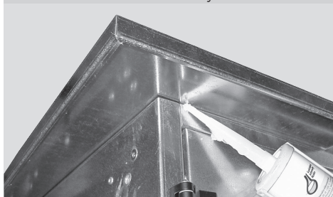
Obrázek 13 – utěsnění rubu stříšky
