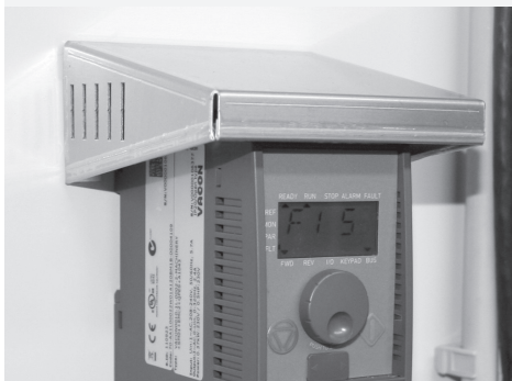
Obrázek 2 – krytí frekvenčního měniče (IP4X)
