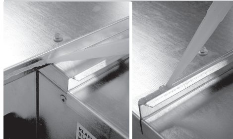
Obrázek 10 – utěsnění stříšek
