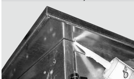
Obrázek 13 – utěsnění rubu stříšky
