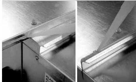
Obrázek 10 – utěsnění stříšek
