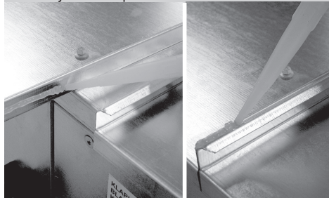
Рис. 10 – уплотнение крышек
