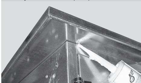
Рис. 13 – уплотнение нижней стороны крышки
