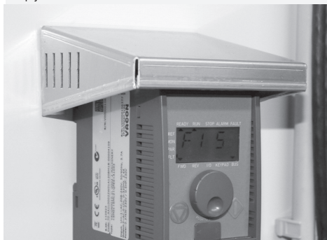
Рис. 2 – кожух частотного преобразователя (IP4X)
