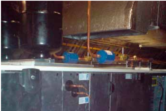
Sklad leteckého petroleje a motorové nafty (ČR) - přesná regulace vlhkosti a teploty v omezeném rozsahu
