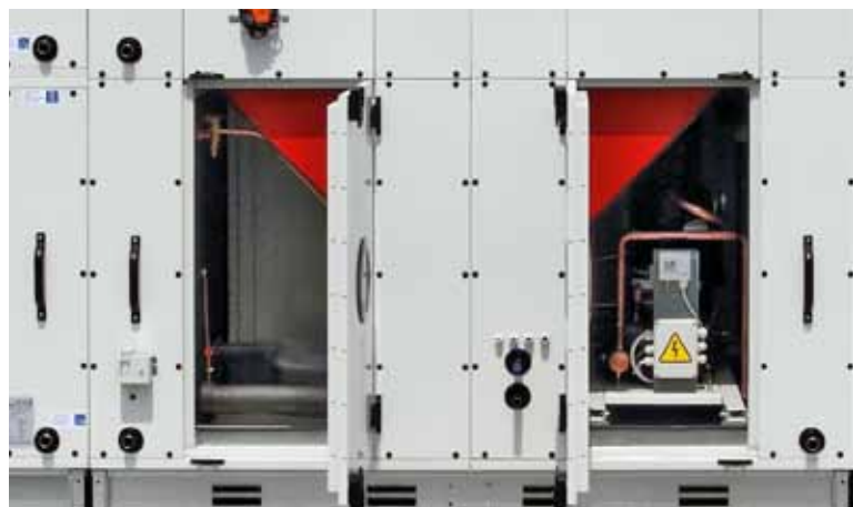
Plavecký bazén (Swiss) – odvlhčování, větrání a vytápění bazénové haly
