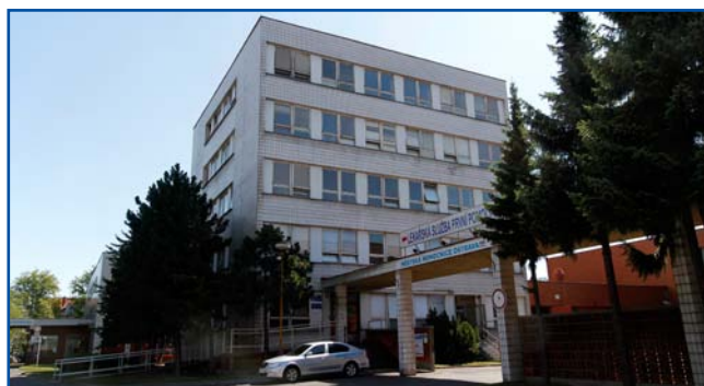
MĚSTSKÁ NEMOCNICE Ostrava, Česko
