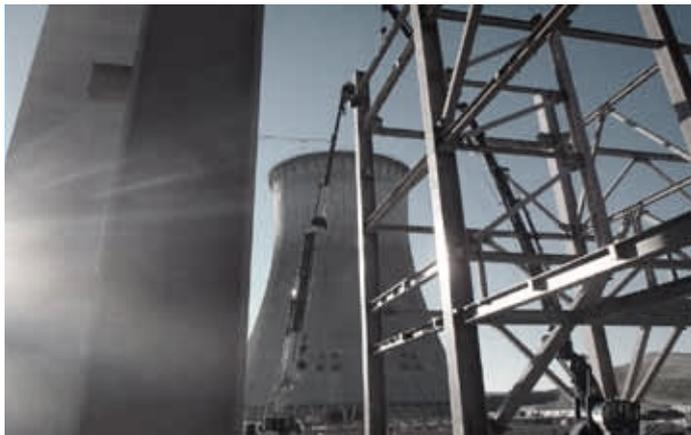
Строительство конструкции котельной, на которой расположено несколько вентиляционных установок REMAK и в случае землетрясения понесет наибольшую динамическую нагрузку.
