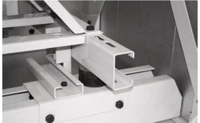
Встроенное устройство вентилятора AeroMaster XP с повышенным стоечным профилем и silentблоками с упорами соответствующими требуемой сейсмической нагрузке.
