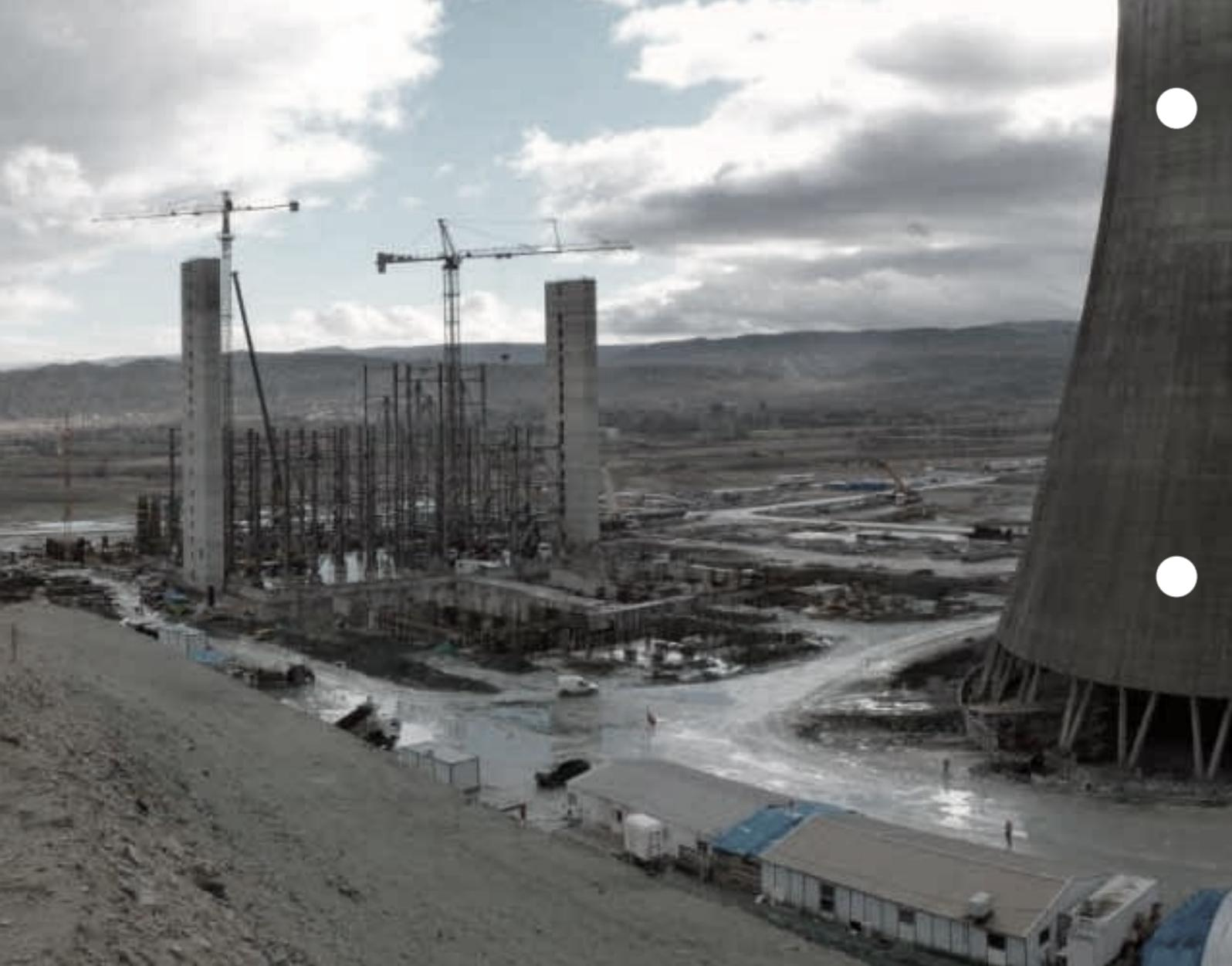
Строительство стальной конструкции котельной, высота охладительной башни 115 м, высота котельной 53 м.
