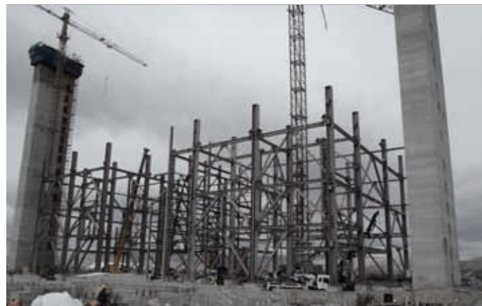
Výstavba konstrukce kotelny, na které je umístěno několik vzduchotechnických jednotek REMAK, které v případě zemětřesení budou snášet největší dynamické zatížení.
