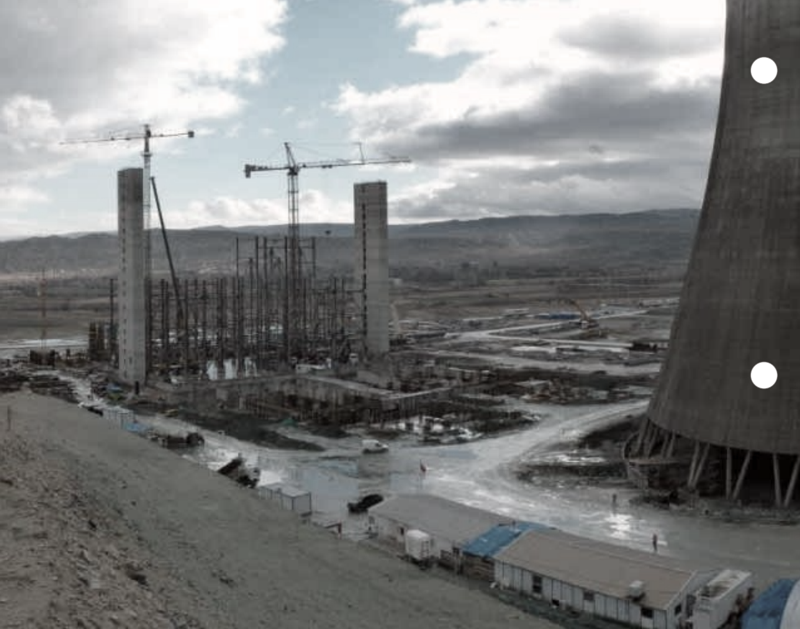
Výstavba ocelové konstrukce kotleny, výška chladící věže je 115 m, výška kotleny pak 53 m.
