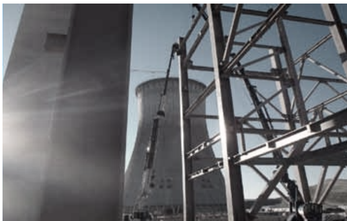
Stavba ocelové konstrukce kotelny, v pozadí chladicí věž.
