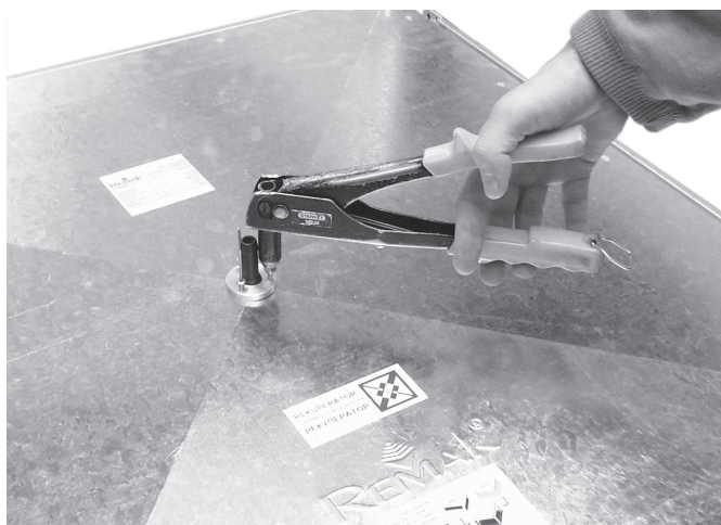
OBRÁZEK 11 – INSTALACE PVC VYÚSTKY
