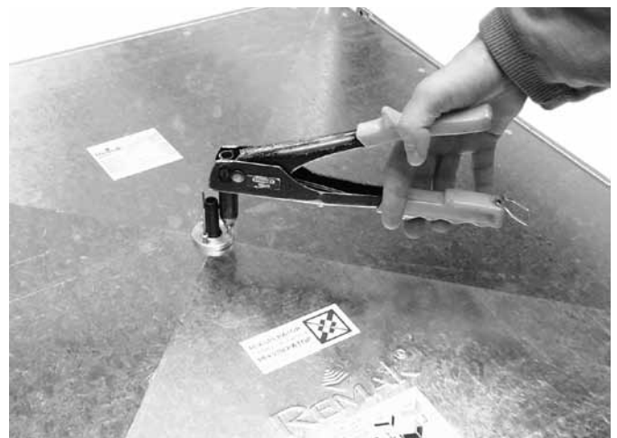
OBRÁZEK 11 – INSTALACE PVC VYÚSTKY
