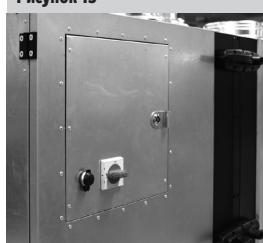
Защита жестяного шкафа IP44 при закрытой двери и IP20 при открытой двери. Все части шкафа изготавливаются загибанием стальных листов с металлизированным защитным слоем Zn 275 g/m<sup>2</sup> и оснащены защитной окраской порошковым лаком. Если вентиляционная установка заказана в наружном исполнении, встроенный
