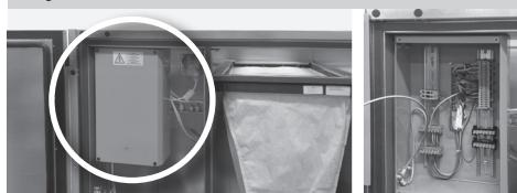
Switchbox), встроенным в вентиляционной установке CAKE (вместо блока управления). На стройке проводится подключение внешнего блока управления с предварительно подключенным шкафом.
