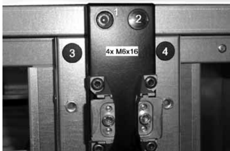
Рисунок 16 - Демонтаж междверной стойки
