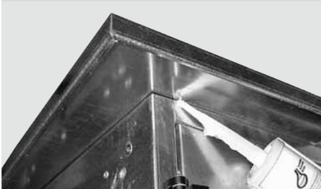
Рис. 13 – уплотнение нижней стороны крышки
