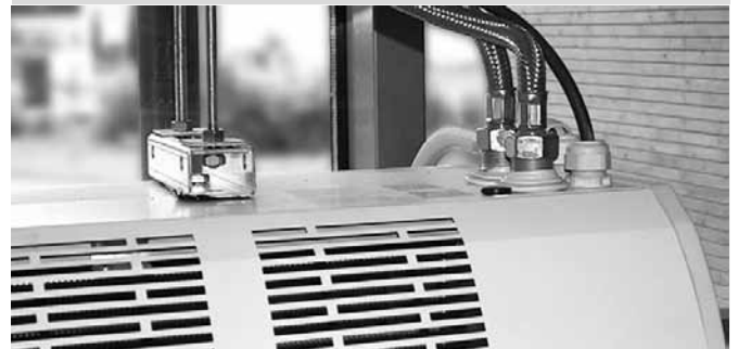
Obrázok 13 – pripojenie vykurov. vody (ohybné hadice)
