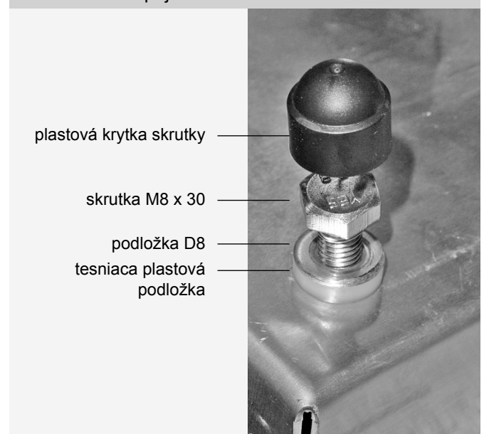
Obrázok 4 – spojenie ventilátora s nástavcom
