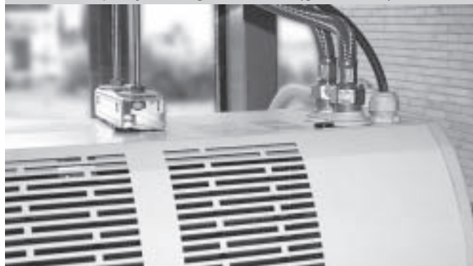
Slika 13 - priključitev grelne vode (gibke cevi)
