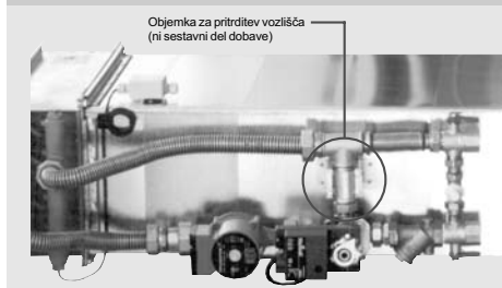
Slika 36 - montaža s pomočjo objemk
