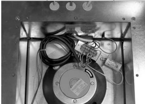
Slika 23 - notranja ureditev elektroinstalacije
