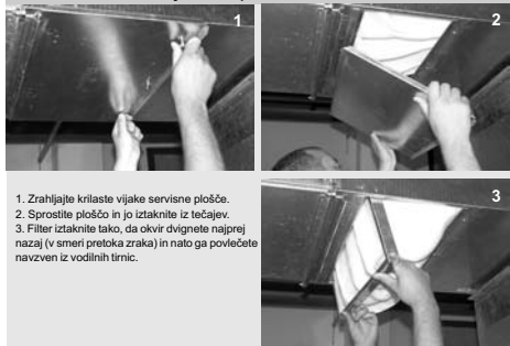
Slika 47 - zamenjava žepa filtra
