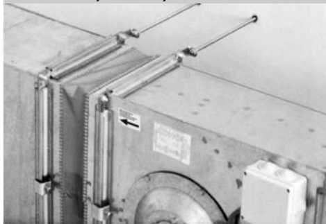
Slika 1 - sidranje ventilatorja
