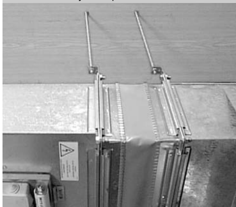
Slika 12 - sidranje v stropu
