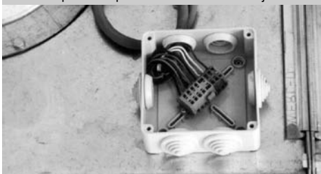
Slika 8 - plastična povezavna letvica na ohišju
