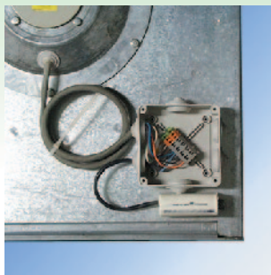
előre elkészített sorkapocs megkönnyíti az elektromos szerelést
