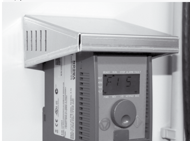
Рис. 2 – кожух частотного преобразователя (IP4X)
