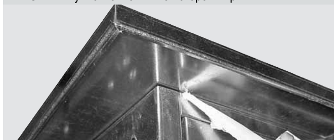
Рис. 14 – уплотнение нижней стороны крышки
