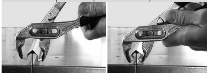
Рис. 12 – закрытие и закрепление стыка крышек
