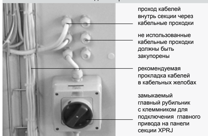
Рис. 4 — кабельные выходы секции
